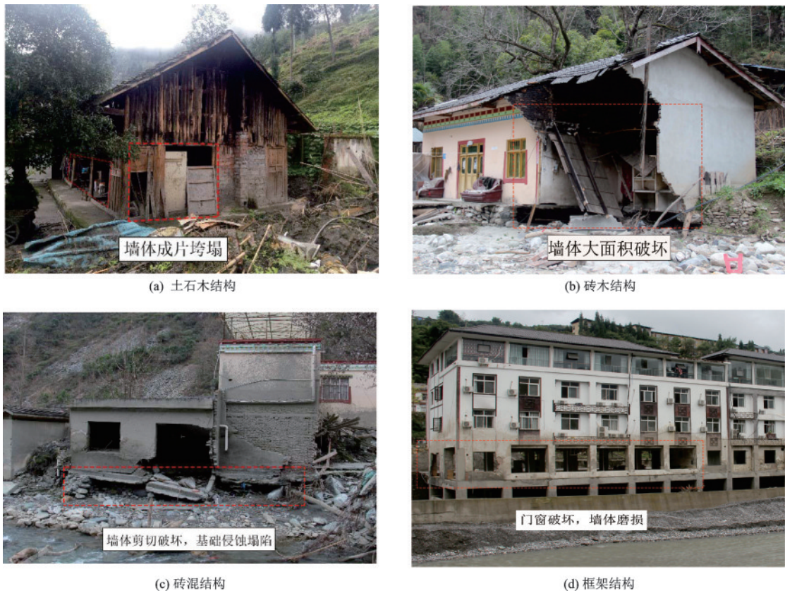
图2 不同结构类型建筑实例破坏情况
